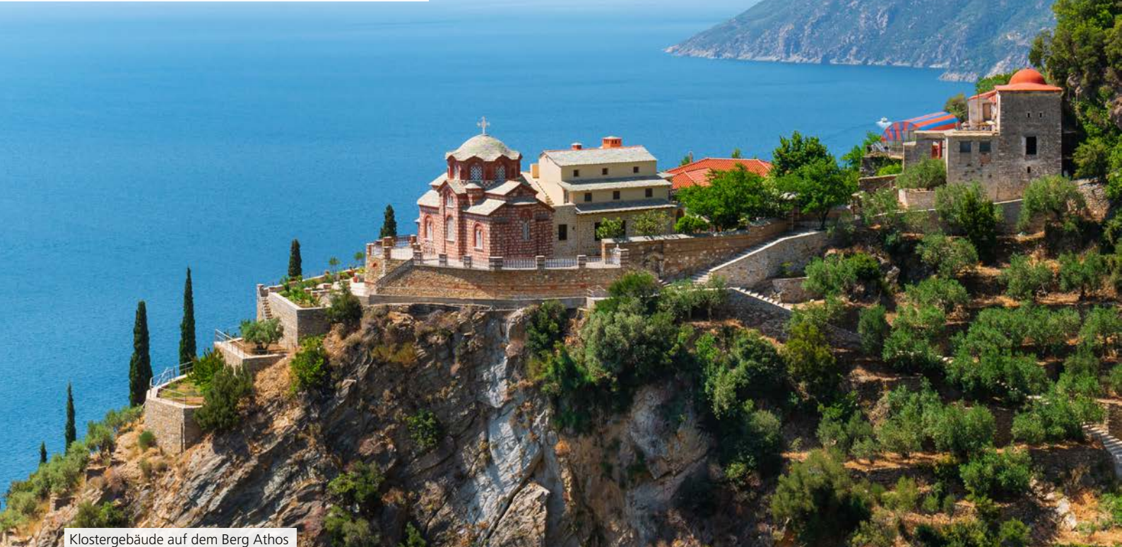
Klostergebäude auf dem Berg Athos
