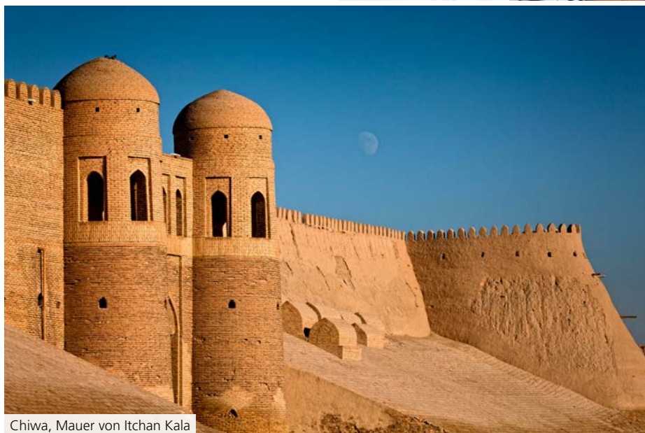
Chiwa, Mauer von Itchan Kala
